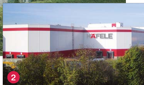
2. Офис и склад "Хефеле Рус" в Москве (МКАД, 14-ый км, д.10)
